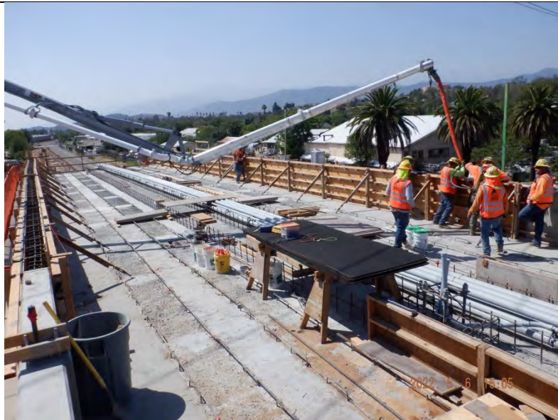
Bonita Cataract—Box girder concrete pour
