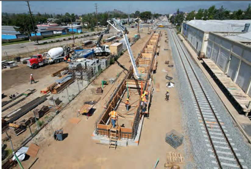
La Verne Station- Wall concrete pour
